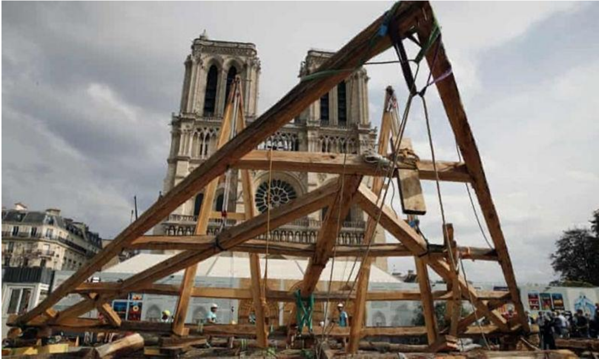
Timmerlieden toonden de vaardigheden van hun middeleeuwse voorgangers door vorig jaar een gedeelte van de Notre Dame-kathedraal te reproduceren.
